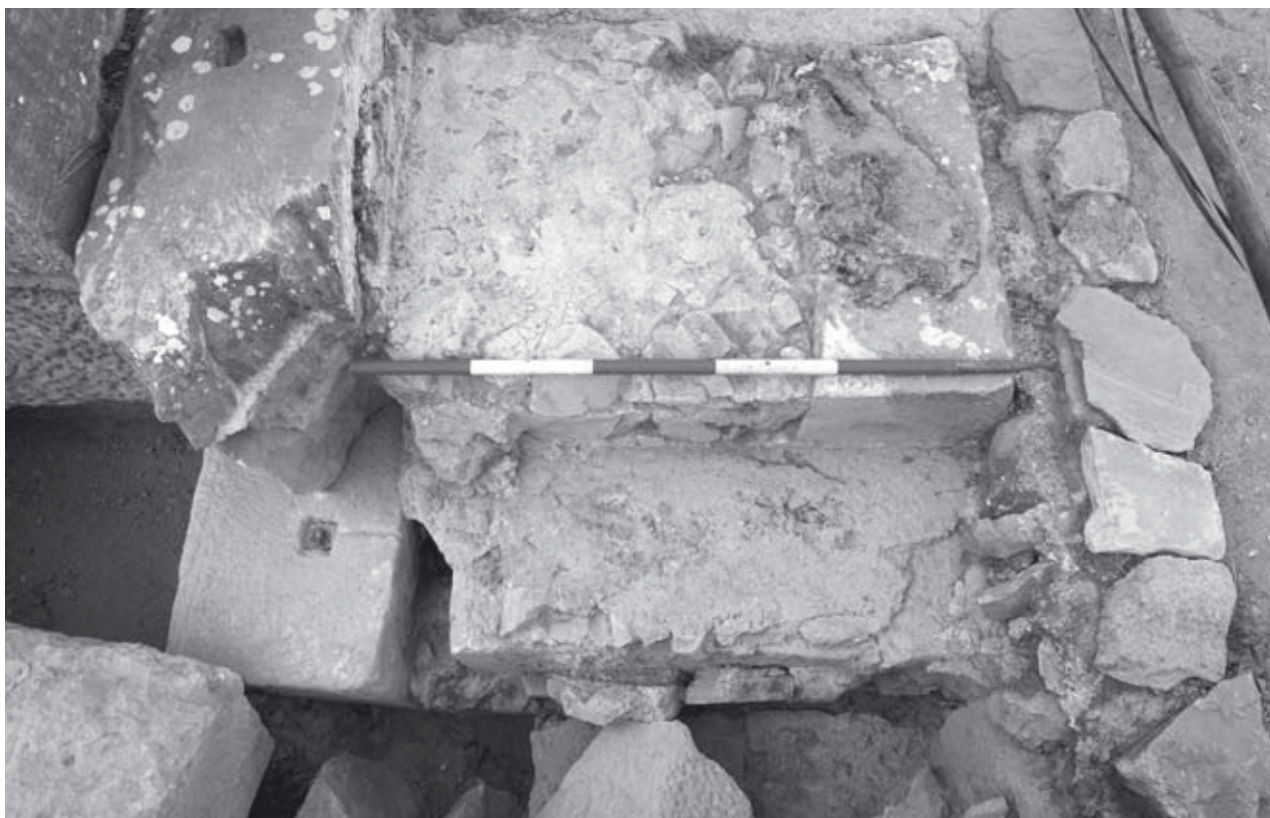
Abb. 82: Bühnengebäude-Nord, Stützpfeiler in NO-Ecke Raum A', N-Ansicht
