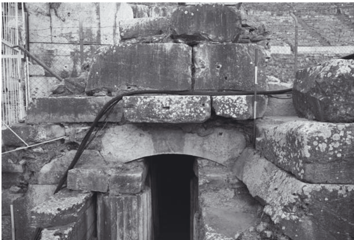
Abb. 85: Bühnengebäude-Nord, westl. Zugang zur Nord-Parodos, Ansatz des einstigen Gewölbes, von W
