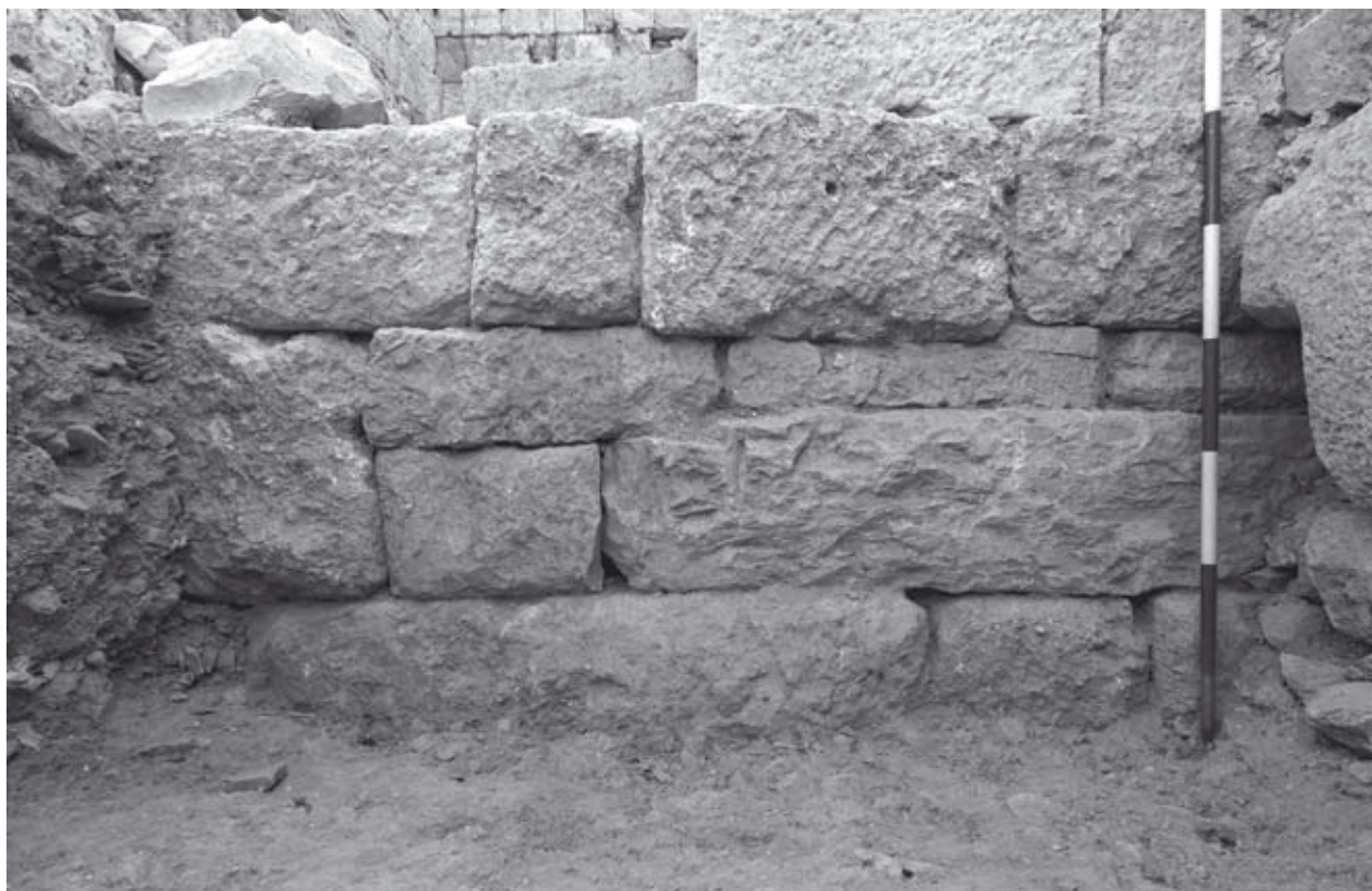
Abb. 38: Kammer E1, Fundament der hell. Westmauer bei D1, W-Ansicht
