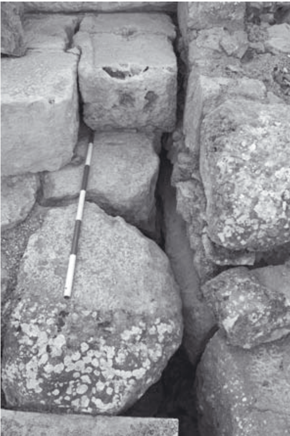
Abb. 78: Bühnengebäude-Nord, Fuge zwischen hell. Terrassenmauer u. kaiserzeitl. Fundament, von W
