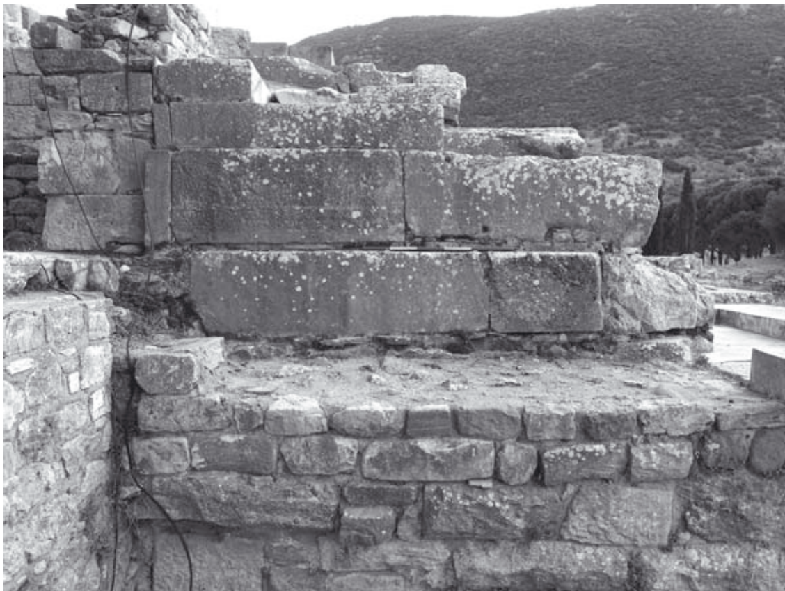
Abb. 86: Bühnengebäude-Nord, byz. Mauerverstärkung westlich Raum RN1, N-Ansicht
