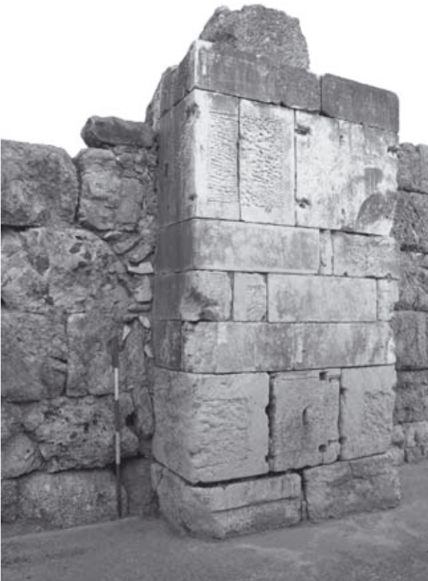
Abb. 59: Dritter Pfeiler von N an der W-Seite von A', im Bereich der Kammern D'3/D'4
