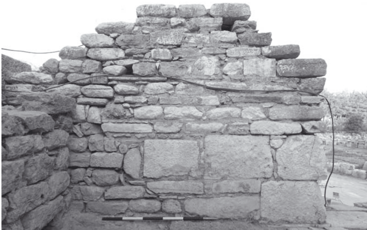
Abb. 70: Raum RN1, Westmauer, O-Ansicht
