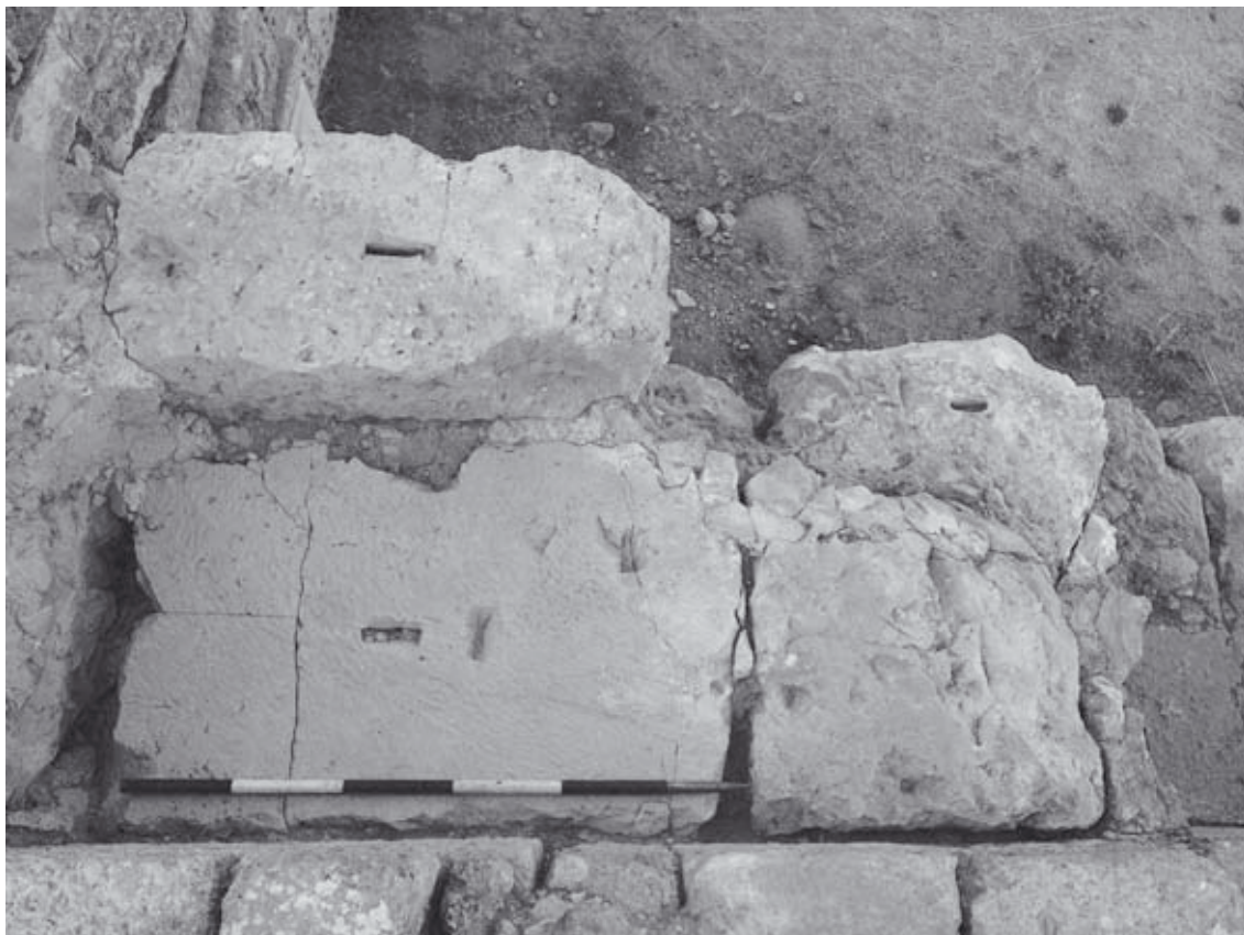
Abb. 94: Bühnengebäude-Süd, kaiserzeitl. Pfeiler im Verbund mit spätem Mauerwerk, N-Ansicht
