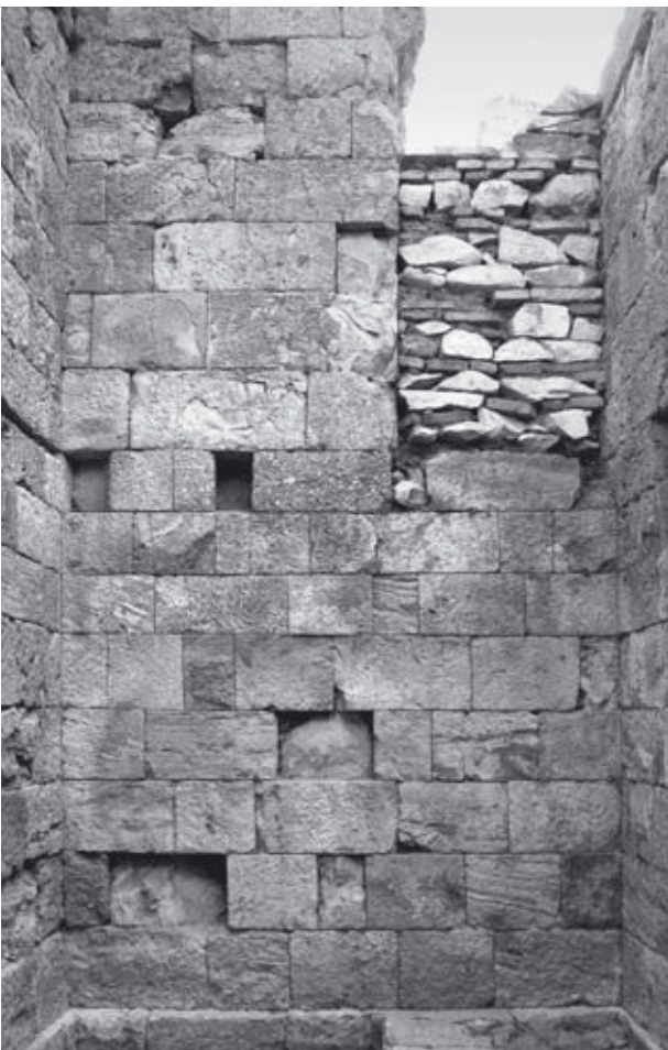
Abb. 57: Kammer D8, O-Wand mit zugemauerter Tür im Obergeschoss, von W
