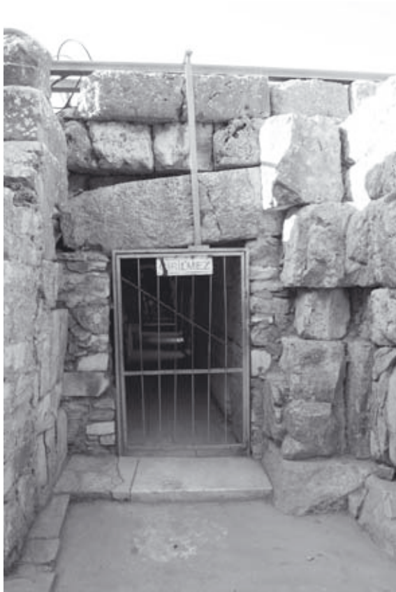
Abb. 83: Bühnengebäude-Nord, Skene N-Eingang, flankiert von kaiserzeitl. Rampe u. T-Pfeiler, von N
