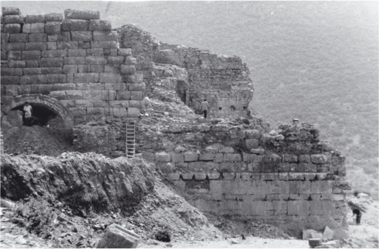
Abb. 15: Freilegungen vor der Nordfassade (1993)
