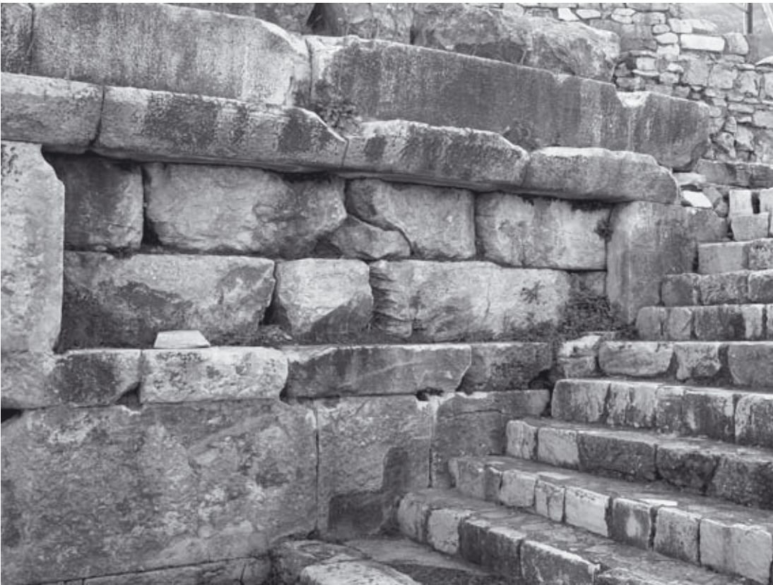
Abb. 23: Unteres nördliches vomitorium EN1. An der Wand sind die Kontaktflächen der Marmorstufen sichtbar.
