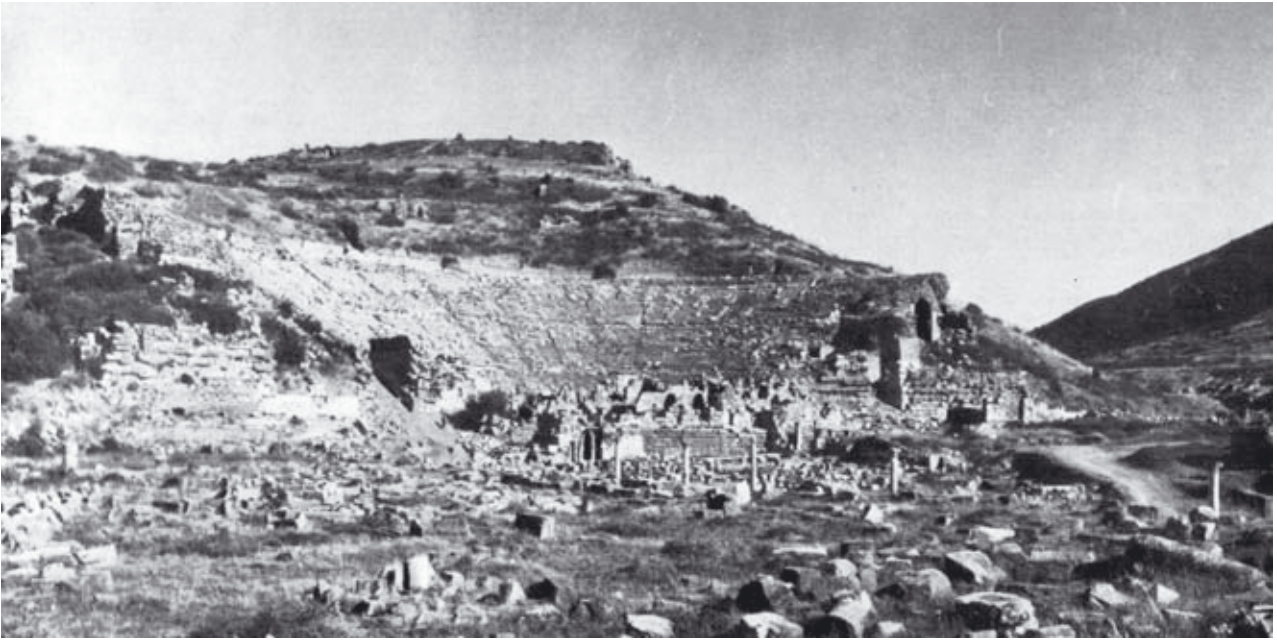
Abb. 13: Ansicht des Auditorium von Westen während der Freilegung (Ende der 1960er Jahre)
