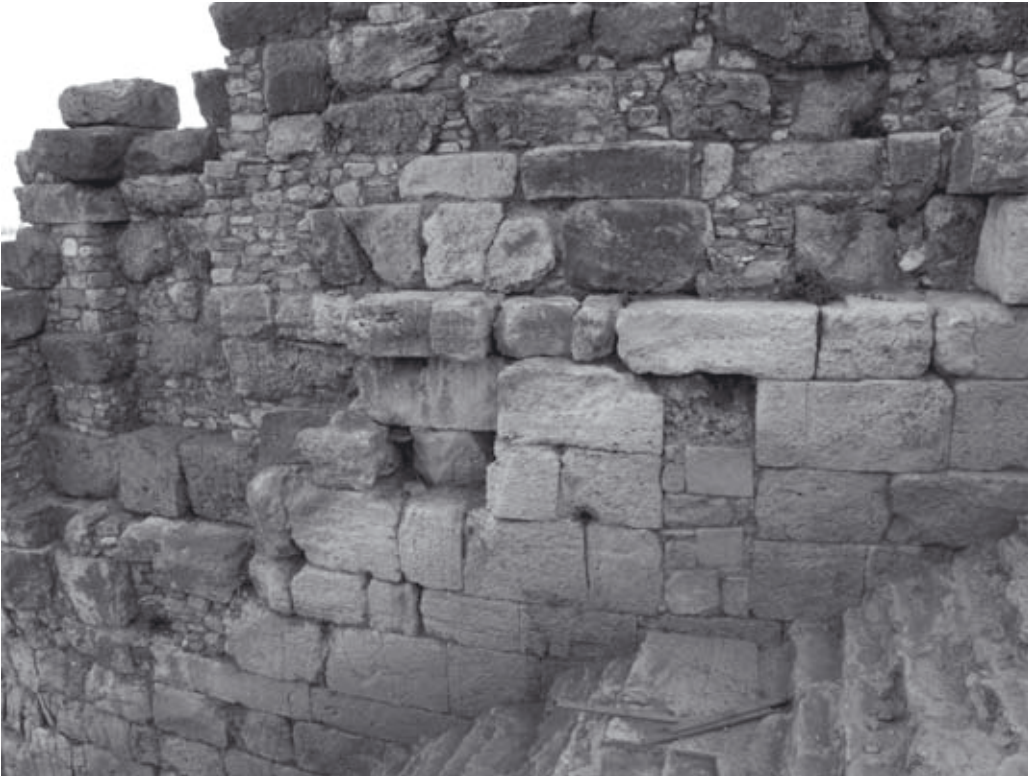
Abb. 25: Südliche Außenwand des Theaters. Restaurierungen (Mauerplomben) der 1990er Jahre
