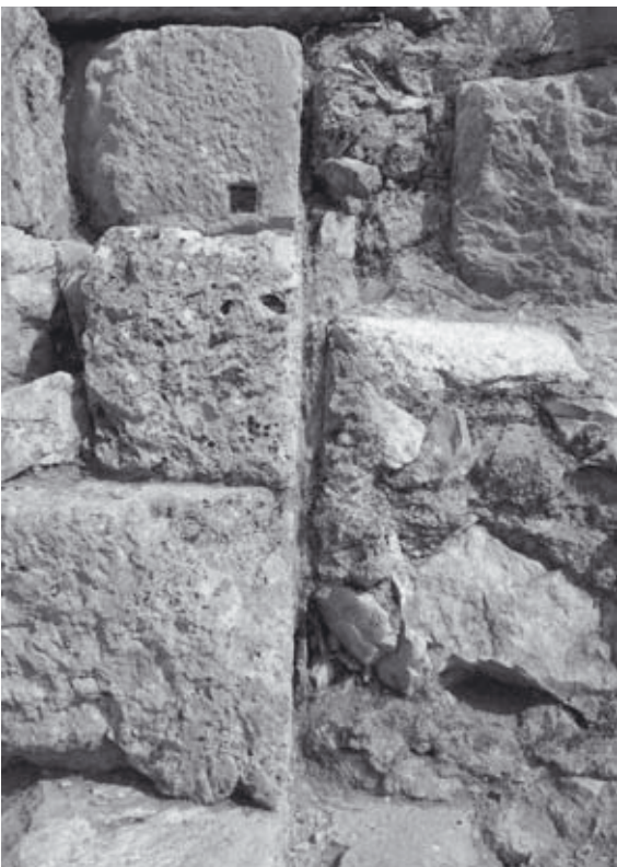
Abb. 92: Bühnengebäude-Süd, Verputzrest zwischen hell. Wand (l.) u. später Mauer (r.), von W
