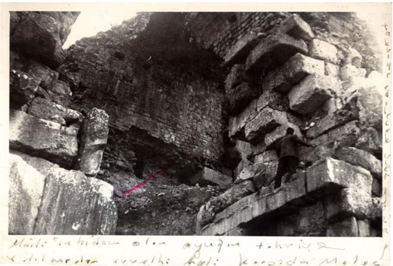
Abb. 10: Arbeiten am Treppenaufgang ES1 West zum unteren südlichen vomitorium ES1 (ca. 1954)
