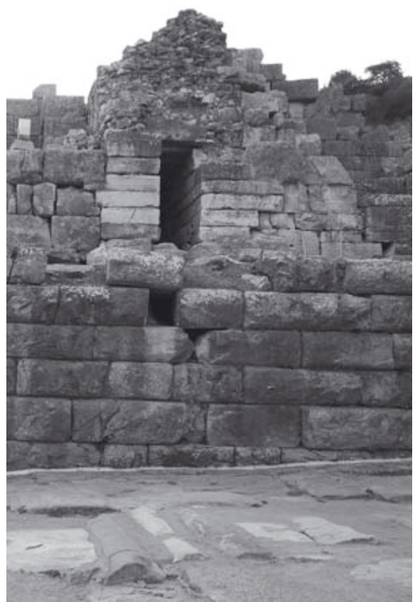
Abb. 98: Byz. Mauer zwischen Kammer E4 u. E5, W-Ansicht
