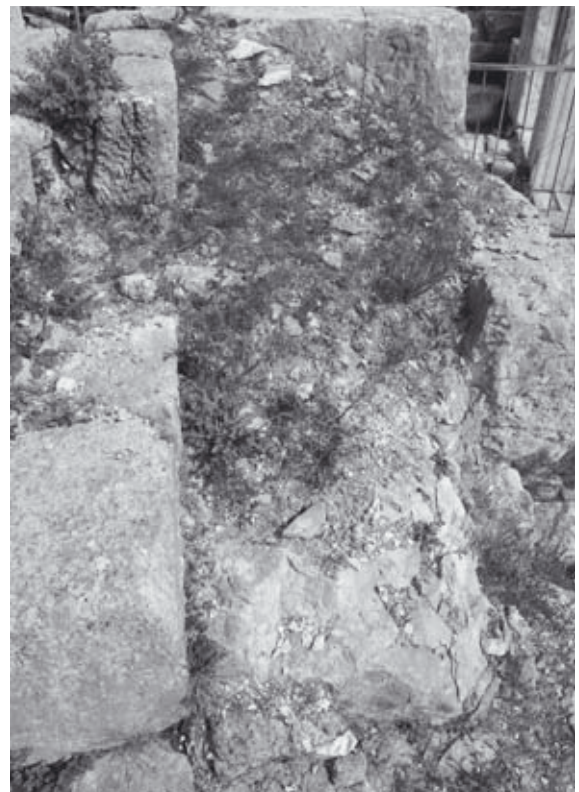
Abb. 93: Bühnengebäude-Süd, kaiserzeitl. Pfeiler im Verbund mit spätem Mauerwerk (vor der Reinigung), W-Ansicht
