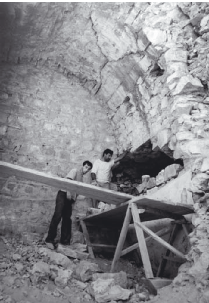
Abb. 14: Restaurierungen in der nördlichen Substruktionskammer SK1 (1993)
