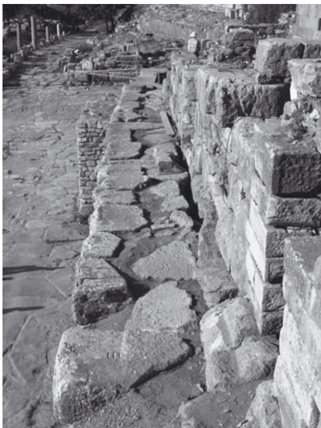
Abb. 87: Terrassenmauer Nord, Aufsicht von S
