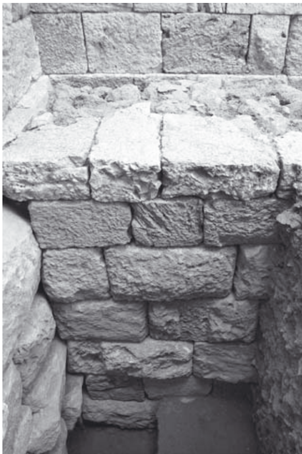
Abb. 34: Kammer D8, S 2/2005, Nordseite Treppenfundament
