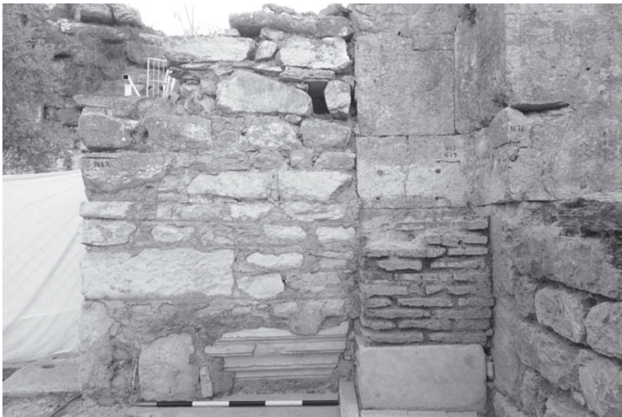
Abb. 71: Raum RN1, Ostmauer, Ziegelpfeiler vor dem kaiserzeitl. T-Pfeiler
