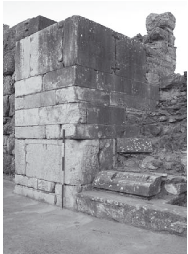
Abb. 60: Fünfter Pfeiler von N an der W-Seite von A' u. der Treppe über C
