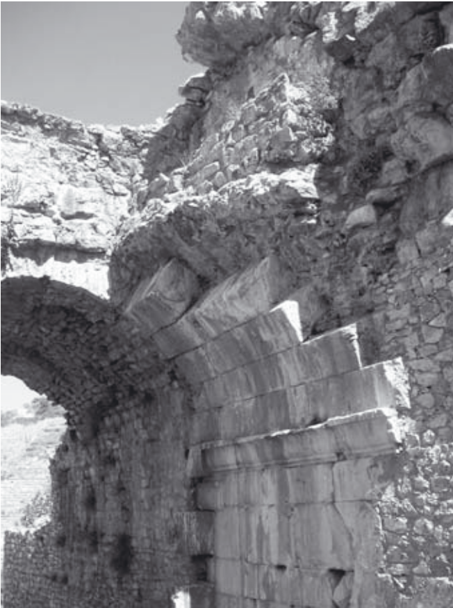
Abb. 22: Unteres südliches vomitorium ES1. Reste des Werksteingewölbes
